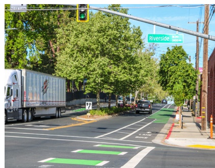
☑ BROADWAY 完整街道 (COMPLETE STREET) 项目
