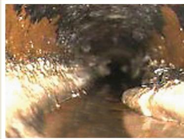
Tubería recubierta de grasa
