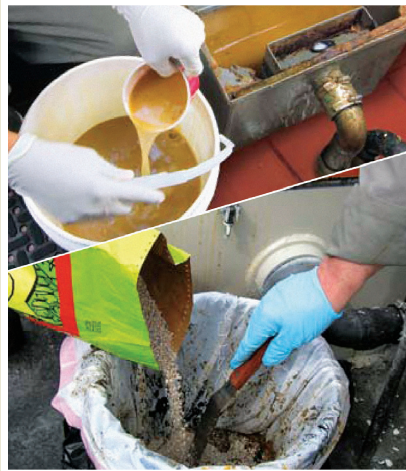
Mantenga limpias las trampas y los interceptores de grasa.
